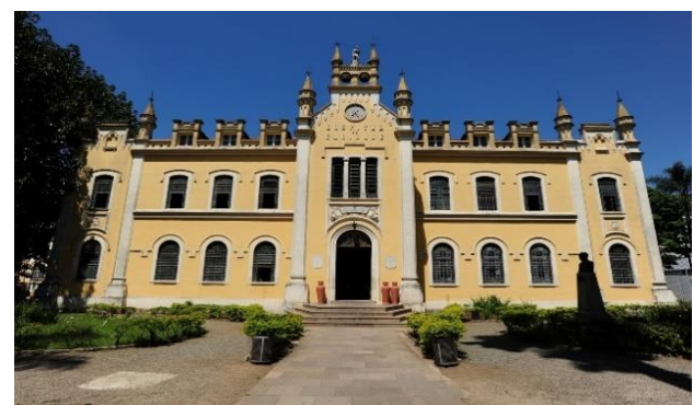
Santa Casa de Misericórdia de Curitiba
